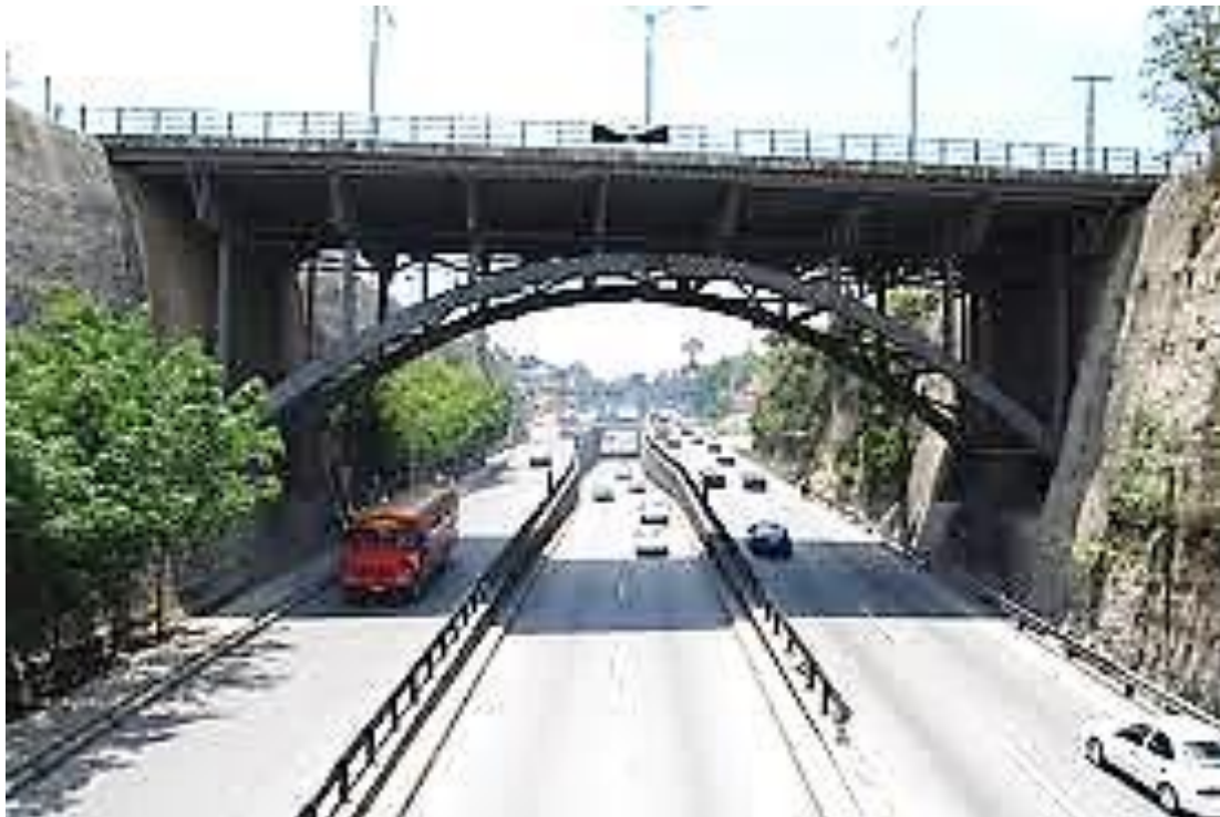
Figura 8. Paso a desnivel sobre carretera al Atlántico, zona 18
