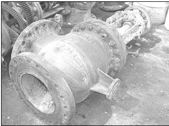
Figura 15. Desmontaje de una válvula
