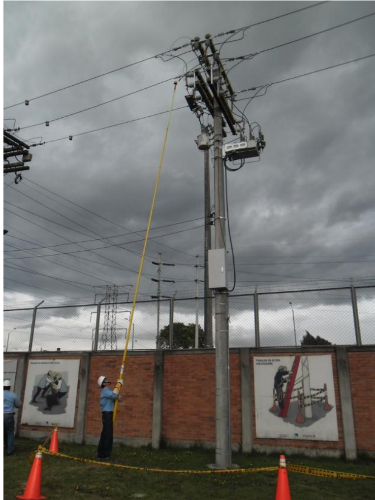
Figura 46. Verificación de ausencia de tensión
