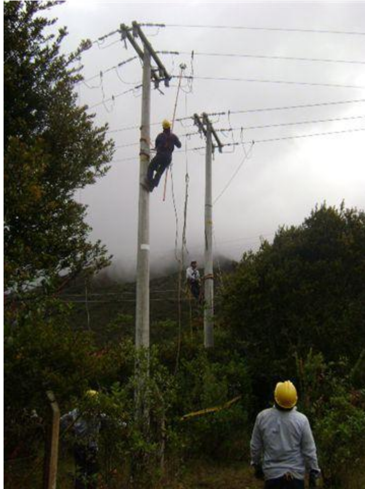
Figura 47. Fijación del sistema de puesta a tierra temporal en la red de media tensión
