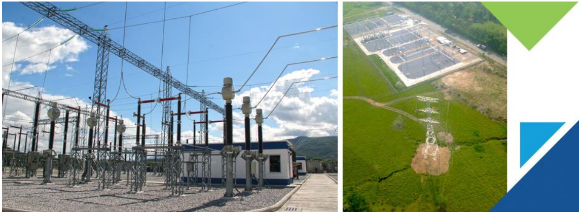
Figura 1. Construcción de estaciones
