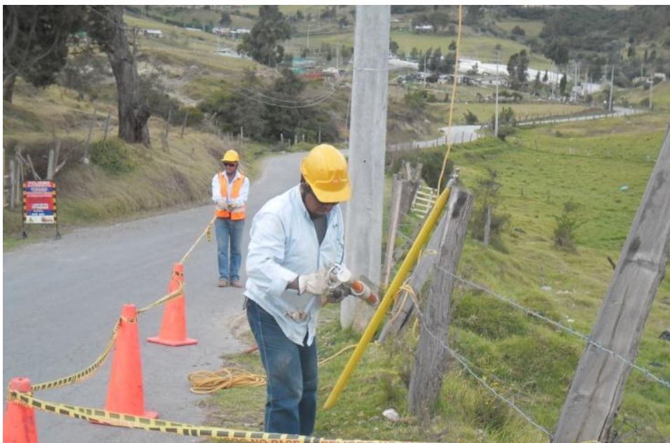
Figura 43. Señalización de trabajo
