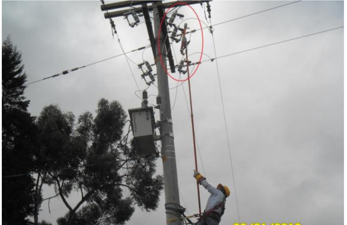
Figura 44. Corte de fuente de tensión
