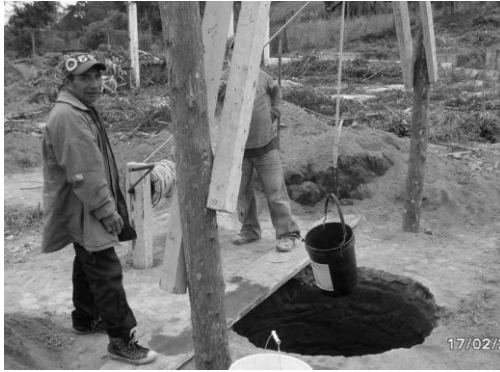
Vista exterior de pozo testigo
