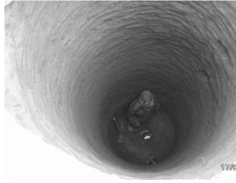
Vista interior de pozo testigo
