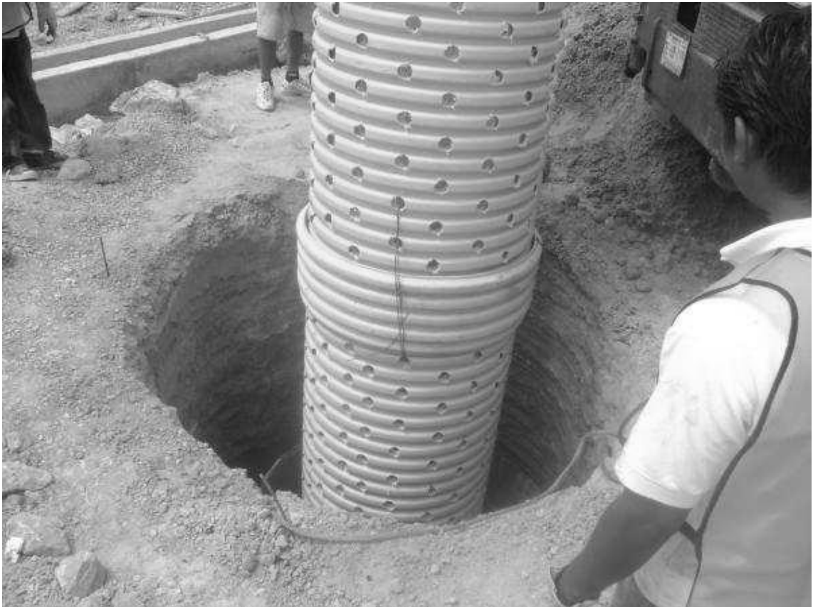
Figura 16. Construcción de un pozo de absorción con elementos prefabricados de Polietileno de Alta Densidad (PEAD)
