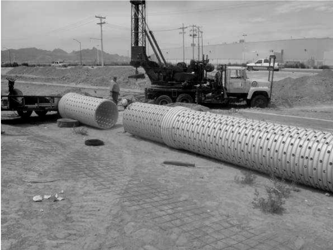
Figura 15. Construcción de un pozo de absorción con elementos prefabricados de Polietileno de Alta Densidad (PEAD)
