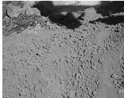
Material final de excavación
