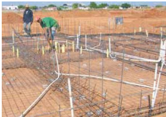
Figura 61. Electromallas en losa de cimentación
