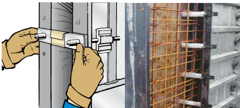
Figura 68. Colocación de corbata
