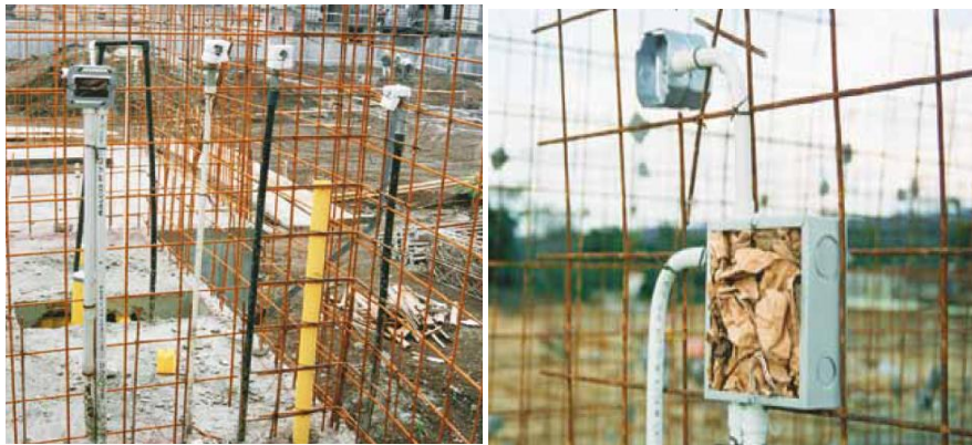
Figura 66. Cajas eléctricas
