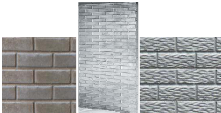
Figura 3. Acabado de ladrillo
