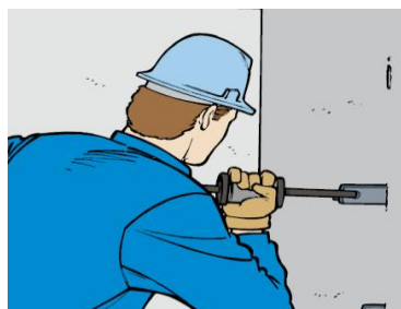
Figura 82. Extracción de sacacorbatas
