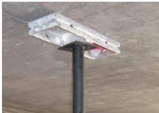
Figura 83. Desencofre en losa
