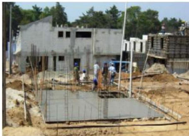
Figura 63. Losa de cimentación finalizada
