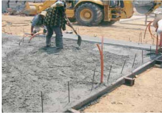
Figura 62. Fundición de la losa de cimentación
