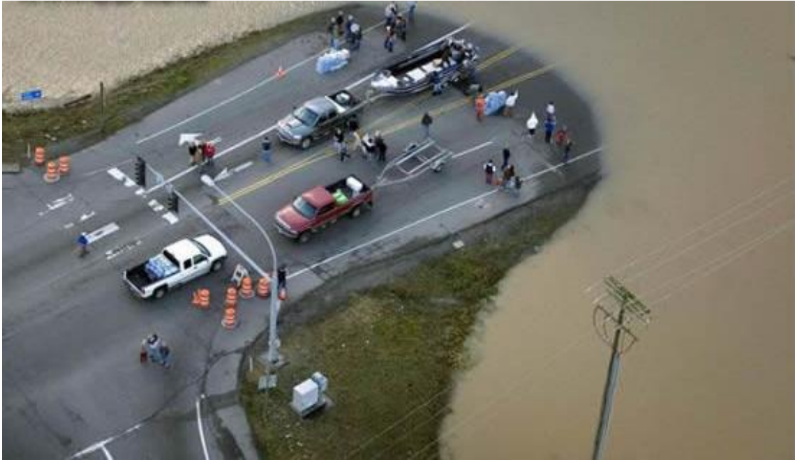
Figura 4. Inundación en carretera
