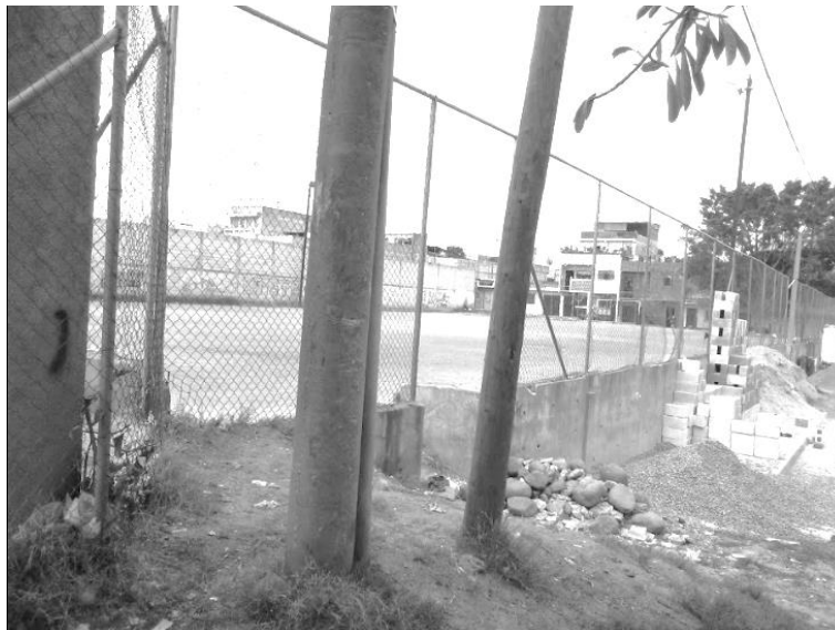
Figura 4. Exterior del campo deportivo
