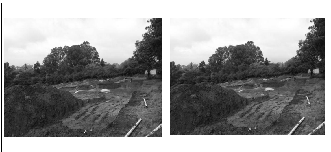
Figura 6. Trabajos preliminares, Condominio Bosques de la Fontana
