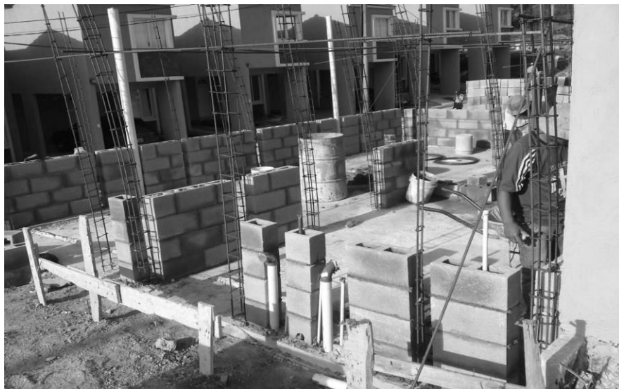
Figura 8. Levantado de muros, Condominio Valle Nuevo
