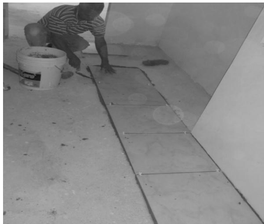
Figura 11. Colocación de azulejo, Condominio Bosques de la Fontana
