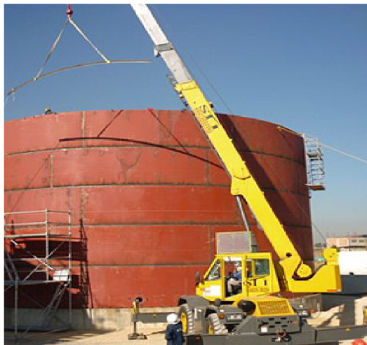
Figura 20. Montaje del cuerpo del tanque
