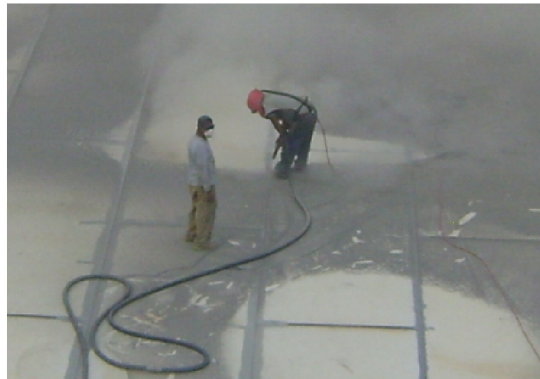
Figura 21. Sandblasting en juntas
