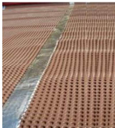
Figura 35. Sellado de traslape de secciones de drenaje nodular
