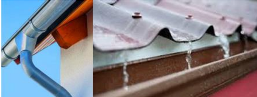
Figura 28. Sistema de drenaje fuera de la estructura
