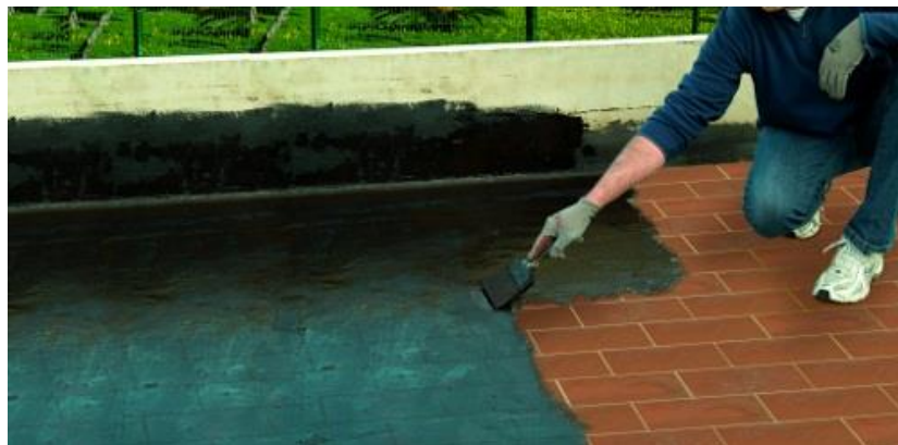
Figura 8. Aplicación de una pintura bituminosa
