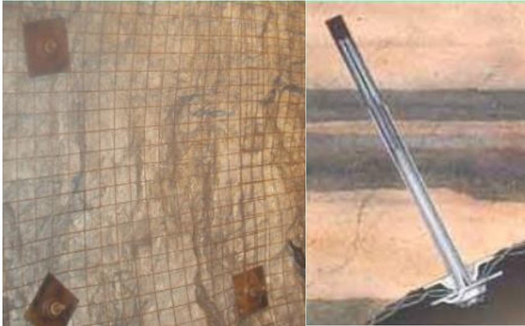
Figura 15. Materiales de sostenimiento (mallas y pernos tipos swellex)
