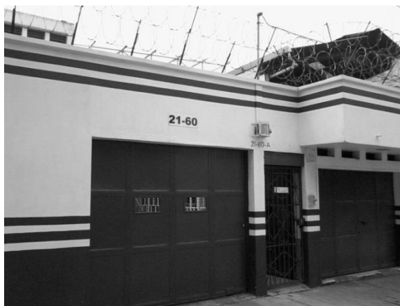
Figura 22. Industria de productos químicos UNISER S.A.
