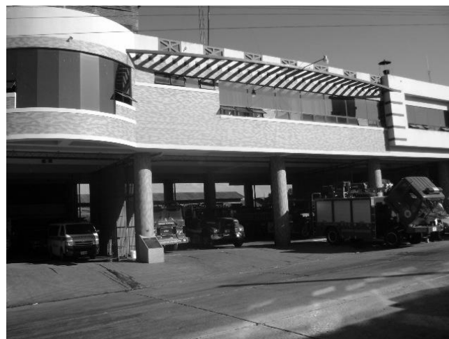
Figura 25. Estación de Bomberos
