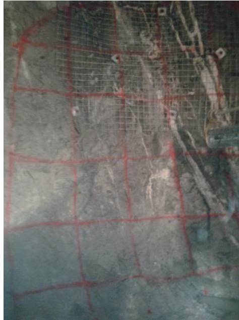
Figura 12. Plantilla de perforación de 4,00 m x 4,50 m
