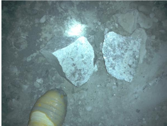
Figura 9. Roca de tamaño considerable en el suelo
