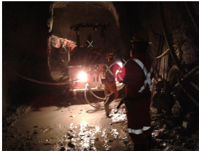
Figura 2. Área de trabajo en mal estado
