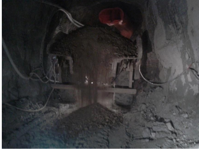
Figura 26. Aplicación de bach seco con camión AD30
