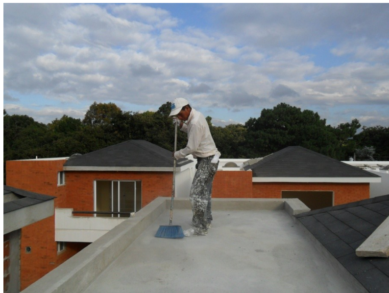
Figura 1. Preparación y limpieza de superficie
