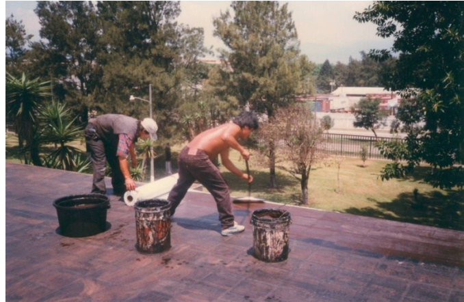
Figura 4. Aplicación de imprimante asfáltico
