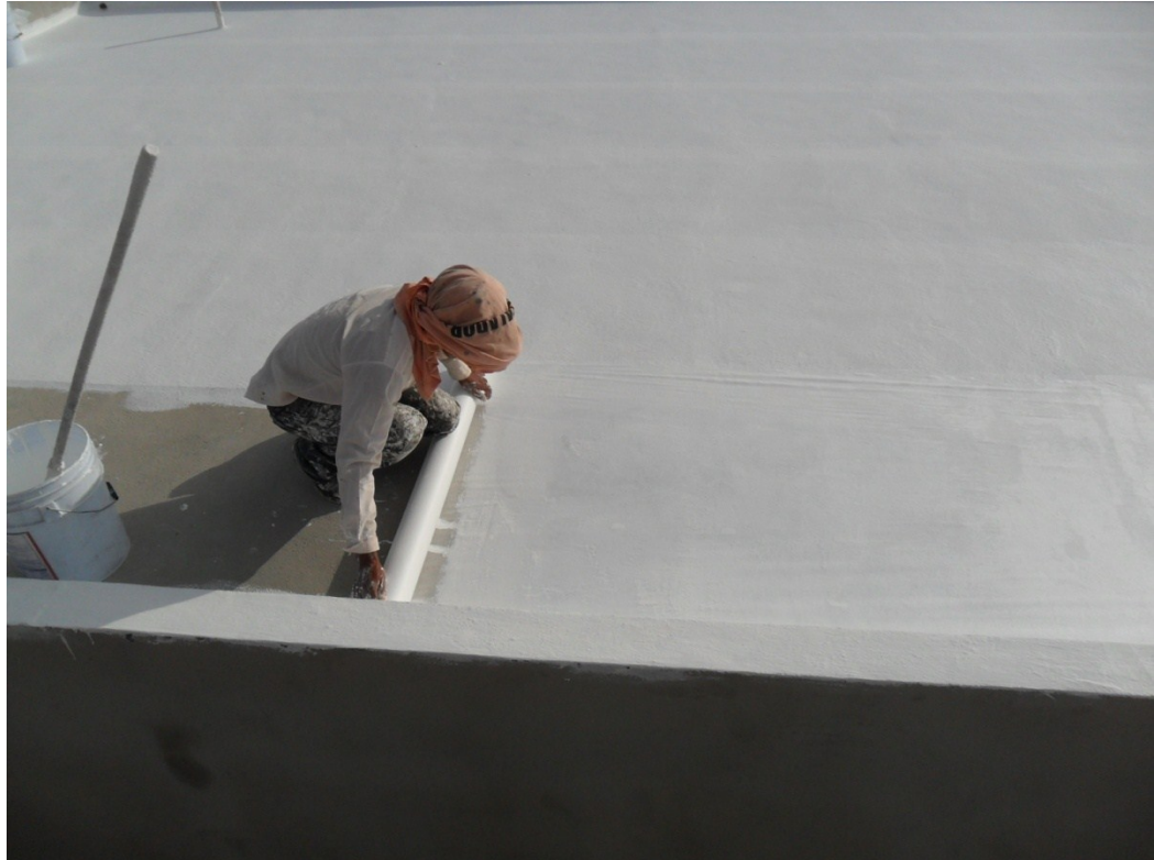
Figura 3. Colocación de membrana de refuerzo
