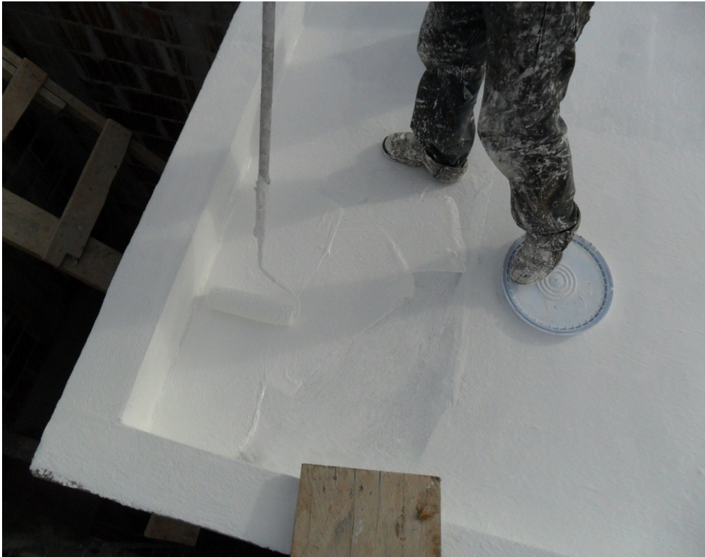
Figura 2. Aplicación de pintura acrílica
