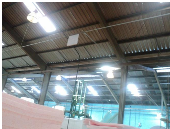
Figura 38. Área de compactado de esponja
