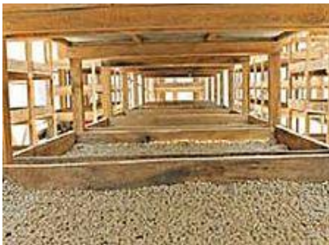
Figura 34. Estructura de una secadora tipo solar
