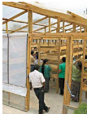
Figura 41. Estructura secadora tipo invernadero
