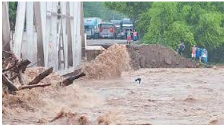
Figura 6. Daños a la población
