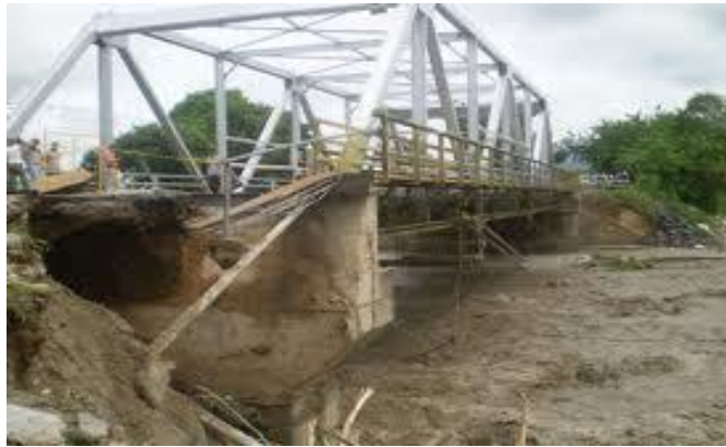
Figura 33. Puente fracturado
