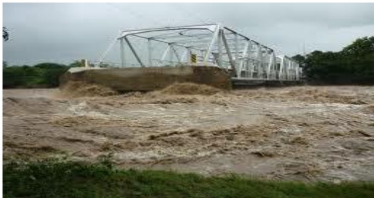
Figura 4. Daños ocasionados por el agua
