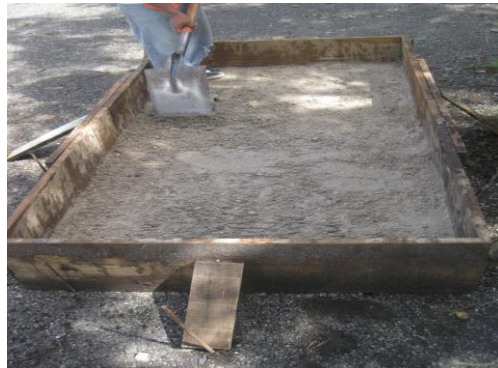
Figura 31. Proceso de compactación, primera fase
