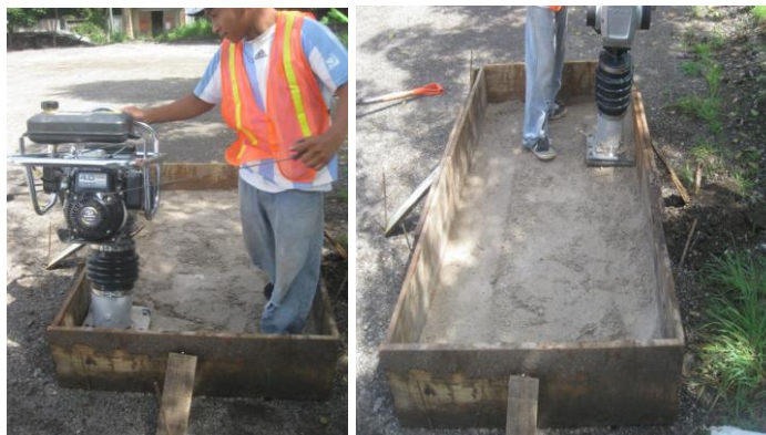
Figura 32. Proceso de compactación, segunda fase
