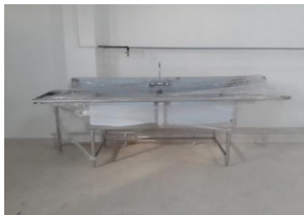
Figura 42. Colocación de lavamanos de dos alas
