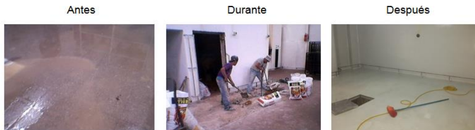
Figura 40. Construcción de drenajes
