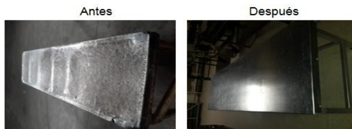
Figura 48. Renovación de equipo del Área de Empaque
