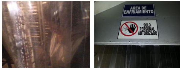
Figura 47. Colocación de cortinas y señalización
