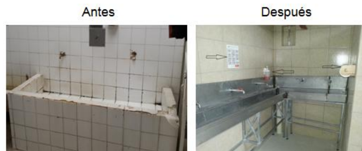
Figura 39. Renovación de lavamanos servicio sanitario
