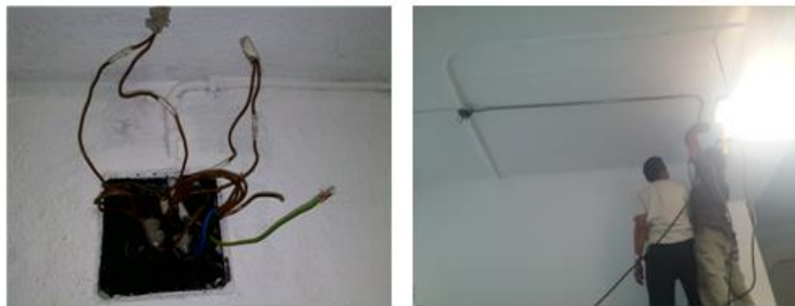
Figura 37. Reestructuración de cableado
