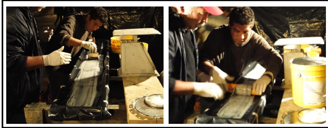
Figura 37. Preparación del refuerzo CFRP embebido de resina epóxica
