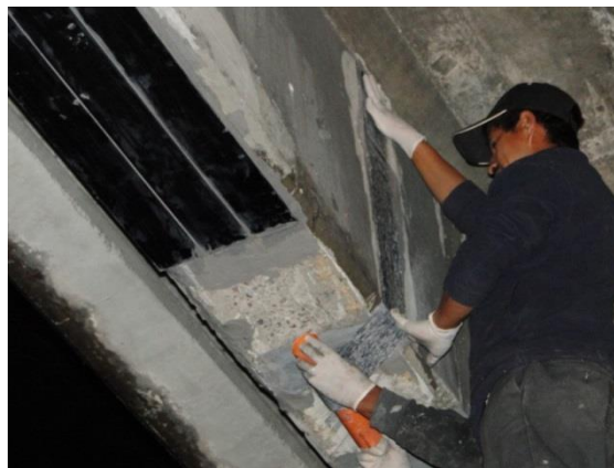
Figura 38. Colocación del refuerzo CFRP a corte
