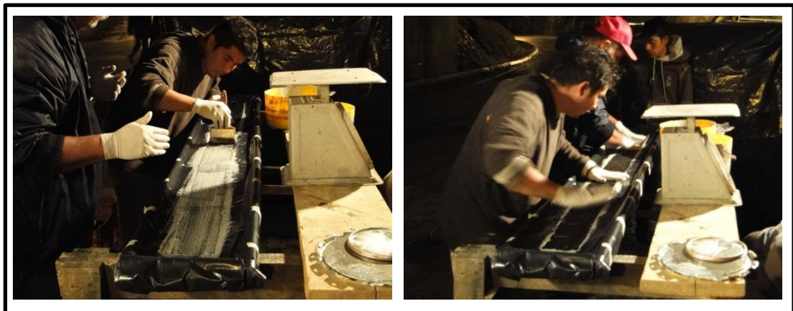
Figura 36. Aplicación de la resina epóxica en el refuerzo CFRP
