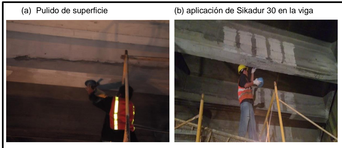
Figura 46. Preparación de la superficie
