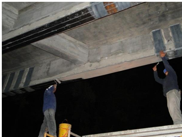
Figura 51. Aplicación de impermeabilizante sobre el refuerzo de fibra de carbono
