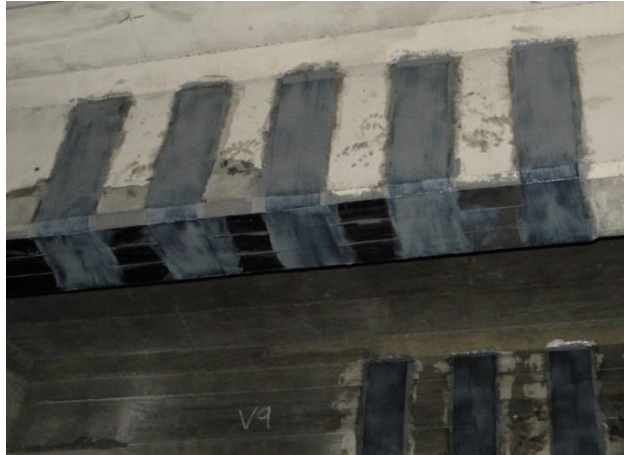
Figura 39. Anclajes en extremos de refuerzo CFRP
