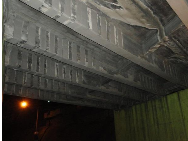
Figura 52. Impermeabilizante aplicado sobre refuerzo CFRP
