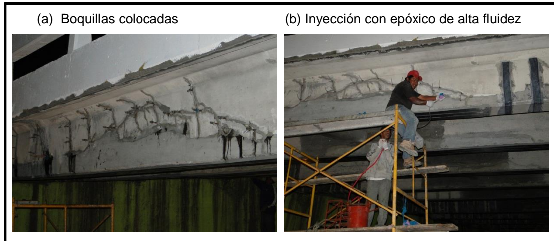
Figura 49. Sellado de grieta en viga 1
