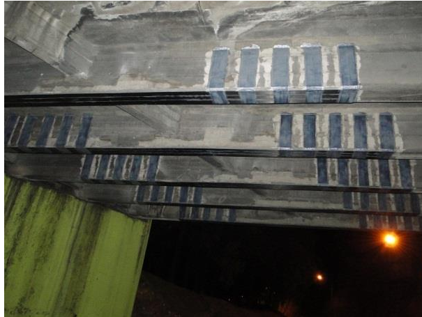
Figura 50. Vista del refuerzo CFRP colocado en las vigas
