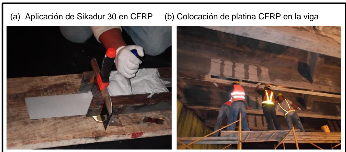
Figura 47. Preparación del platina de refuerzo CFRP
