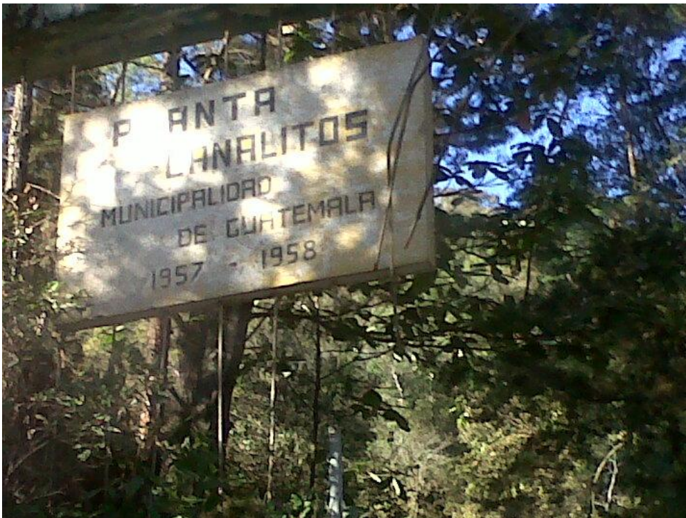
Figura 6. Estación de bombeo
