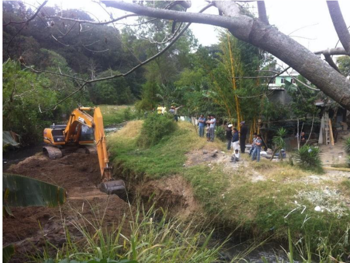
Figura 9. Realización de dragado
