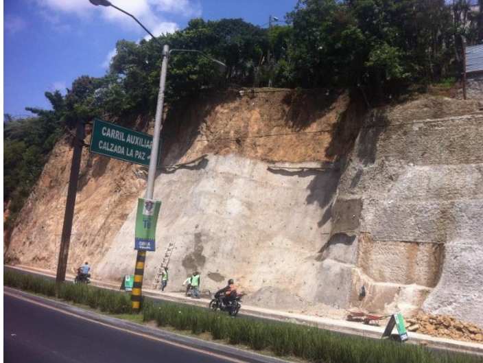
Figura 6. Drenes para salida de agua
