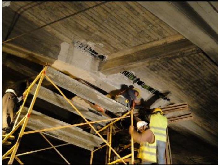
Figura 16. Demolición de loza
