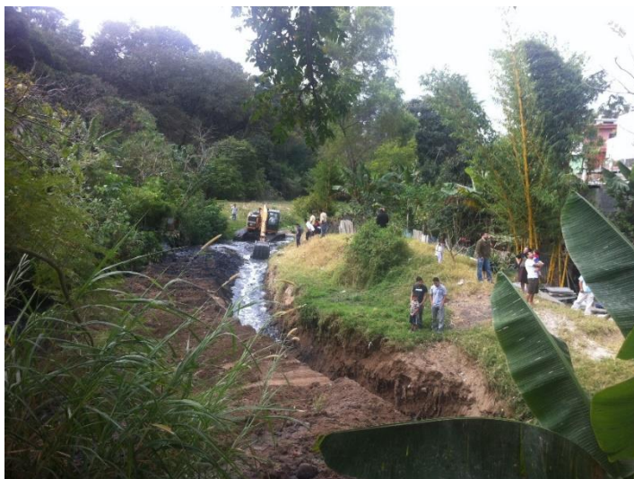
Figura 10. Vía de reorientación del cauce del río
