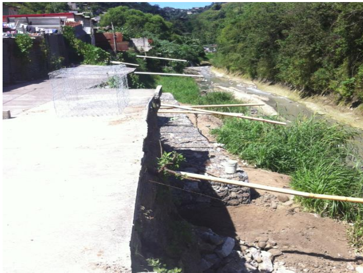
Figura 13. Elaboración del muro de gaviones
