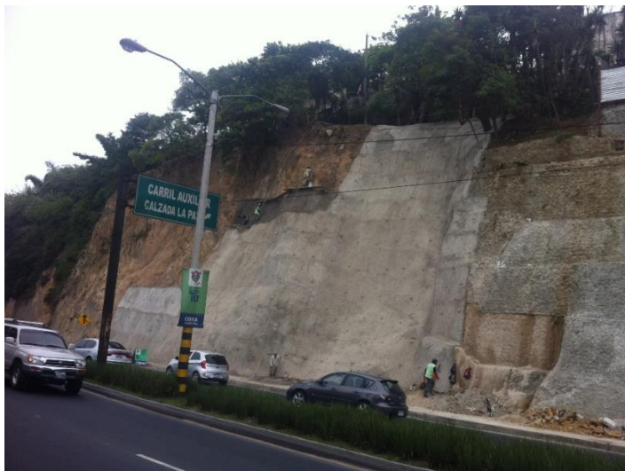
Figura 7. Electromalla y revestimiento de concreto
