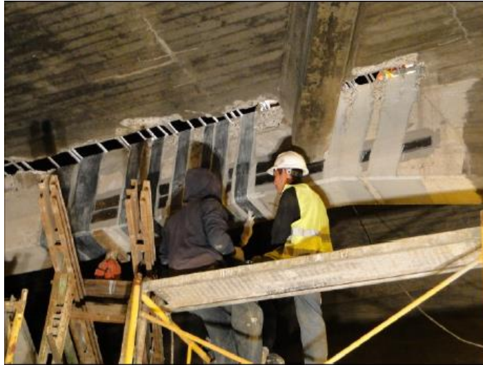
Figura 18. Colocación de malla de carbono
