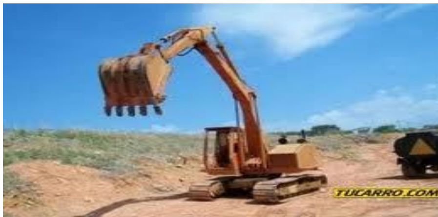
Figura 6. Maquinaria pesada de construcción. Excavadora de oruga Fiat Allis
