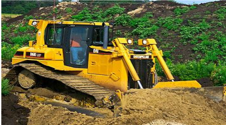
Figura 1. Maquinaria pesada de construcción. Tractor de oruga
