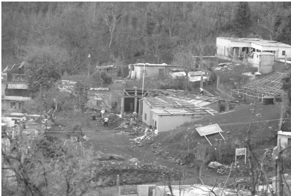
Figura 12. Colapso y daños en techos de viviendas aledañas al volcán de Pacaya
