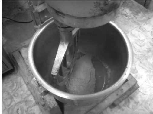
b. Colocación del cemento en la mezcladora de mortero.
