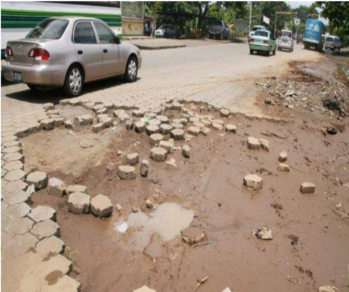
Figura 6. Carretera de adoquín
