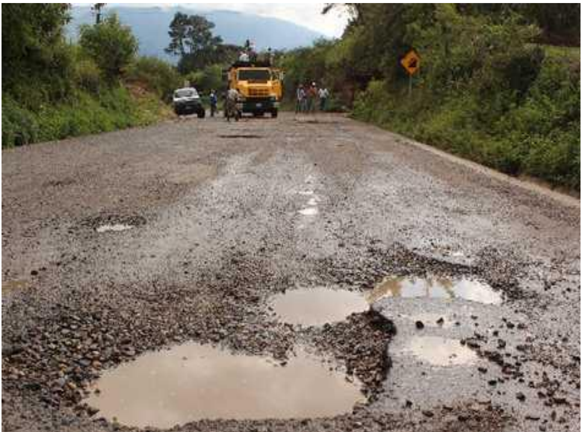
Figura 3. Carretera de balasto
