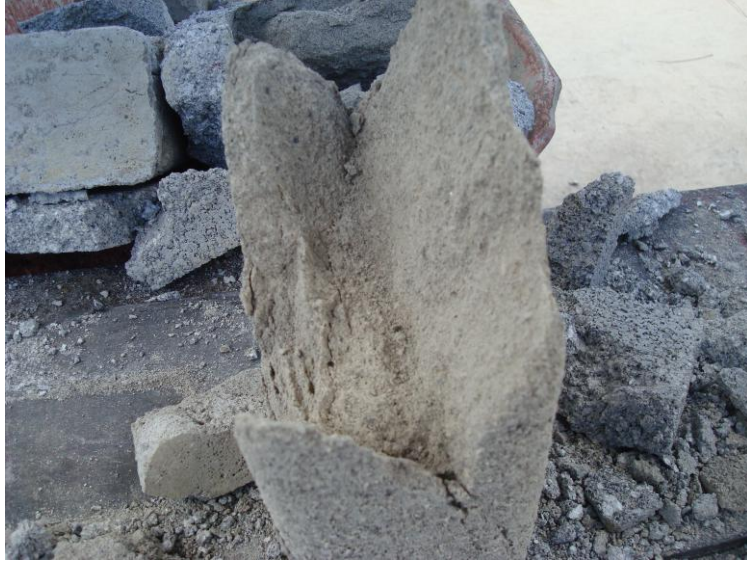
Figura 72. Grout de los prismas
