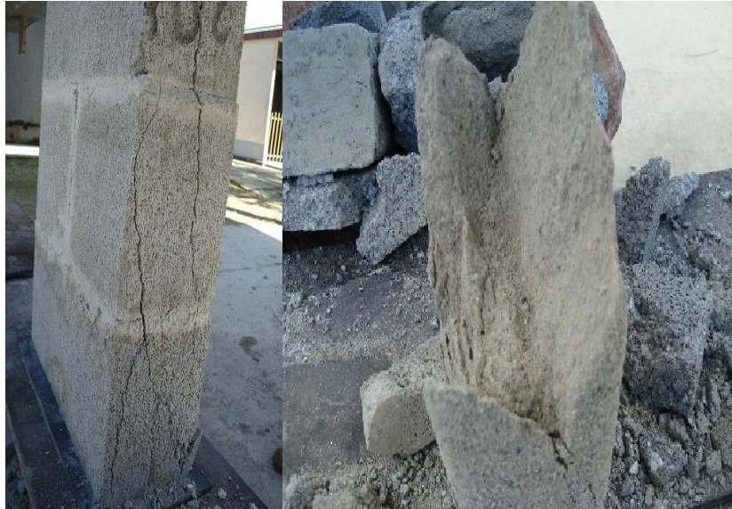
Figura 25. Falla de los prismas de compresión llenos con grout
