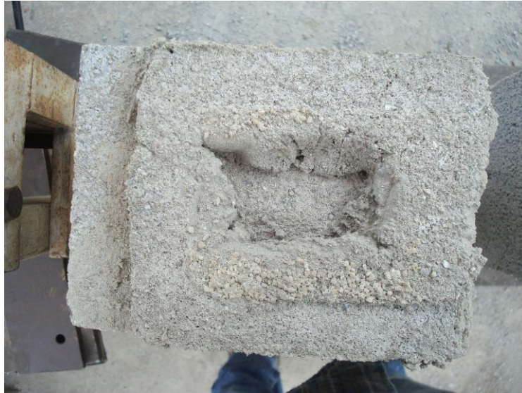
Figura 94. Estado del mortero en los prismas llenos con grout
