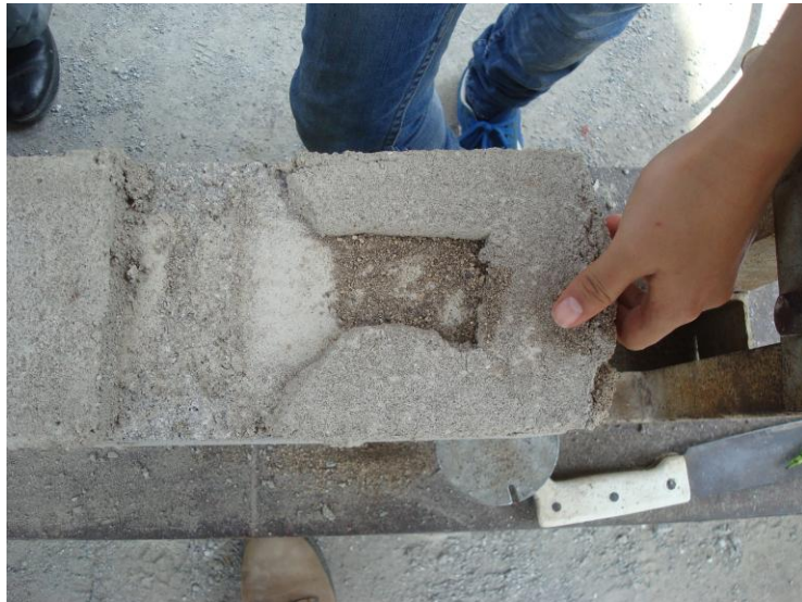
Figura 95. Estado del mortero en los prismas llenos de grout
