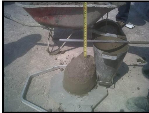
Figura 30. Prueba de asentamiento
