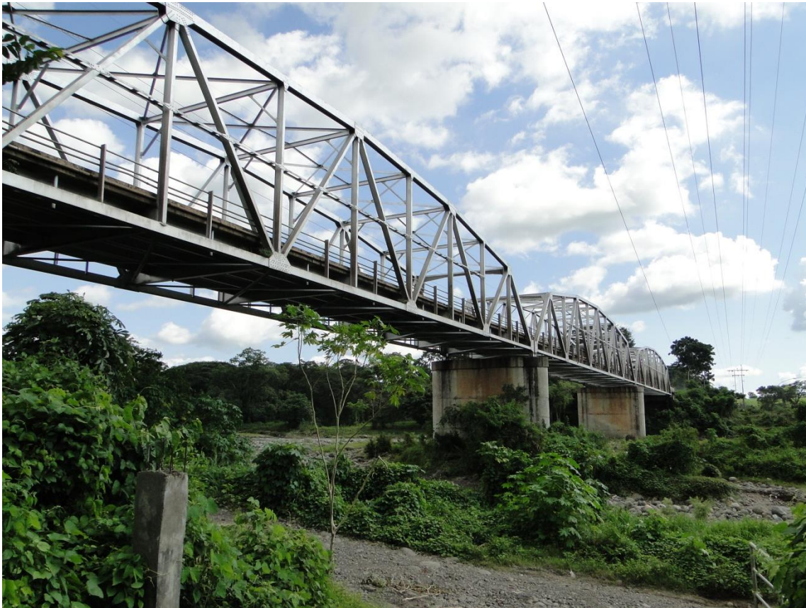
Figura 3. Puente Vado Ancho, Pajapita, San Marcos
