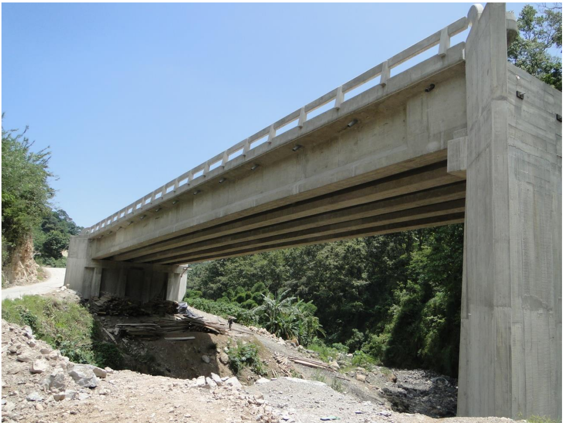
Figura 4. Puente Los Cubes, Palencia, Guatemala
