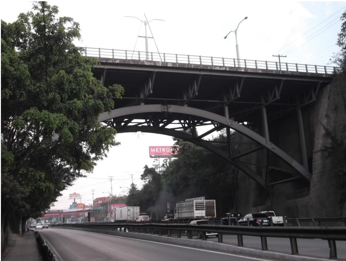
Figura 11. Puente Los Alamos, ciudad de Guatemala
