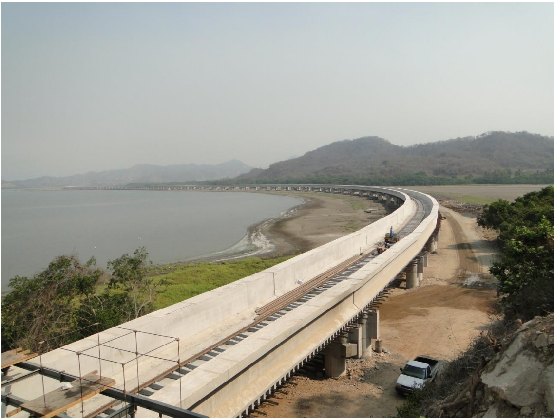
Figura 7. Viaducto ferroviario, Manzanillo, México
