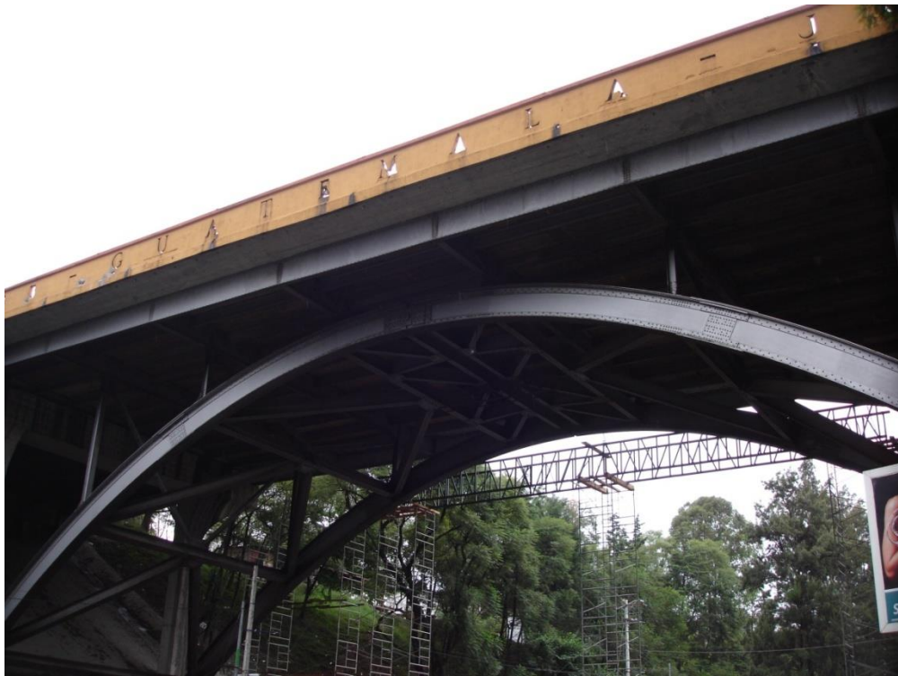
Figura 6. Puente Olímpico, ciudad de Guatemala
