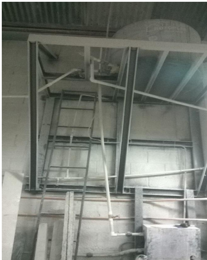
Figura 26. Sistema de reutilización de agua
