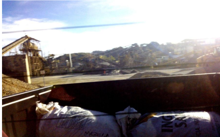
Figura 18. Planta trituradora, zona 6
