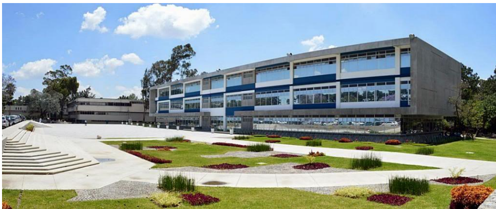
Figura 8. Fotografía edificio dirección general de administración
