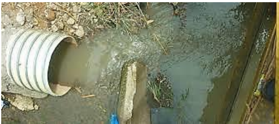
Figura 17. Aguas residuales industriales
