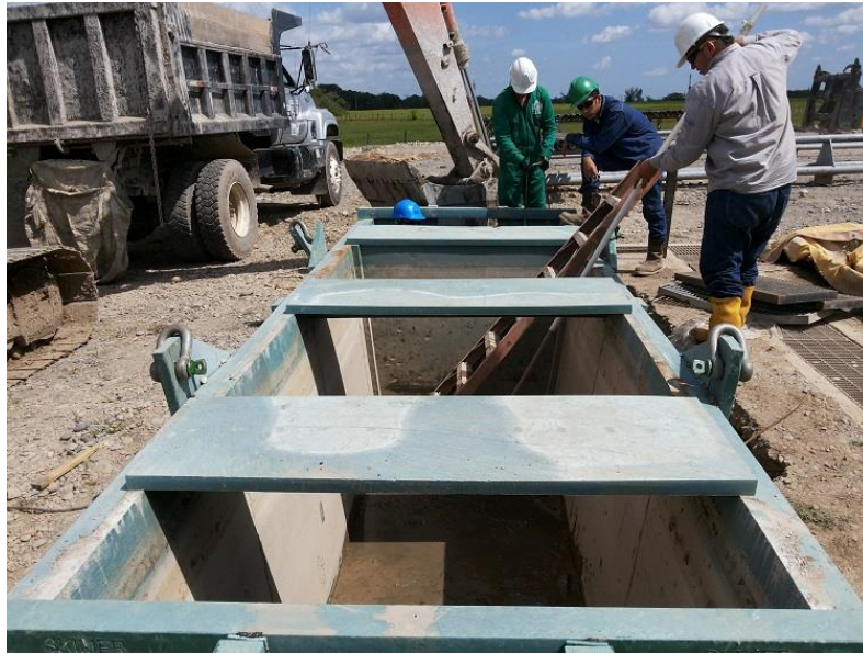
Figura 31. Disposición final extracción de lodo
