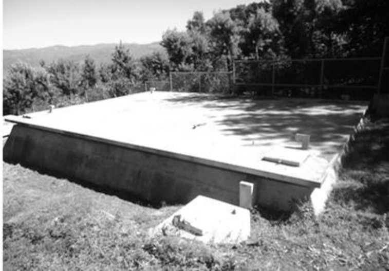
Figura 6. Tanque de almacenamiento
