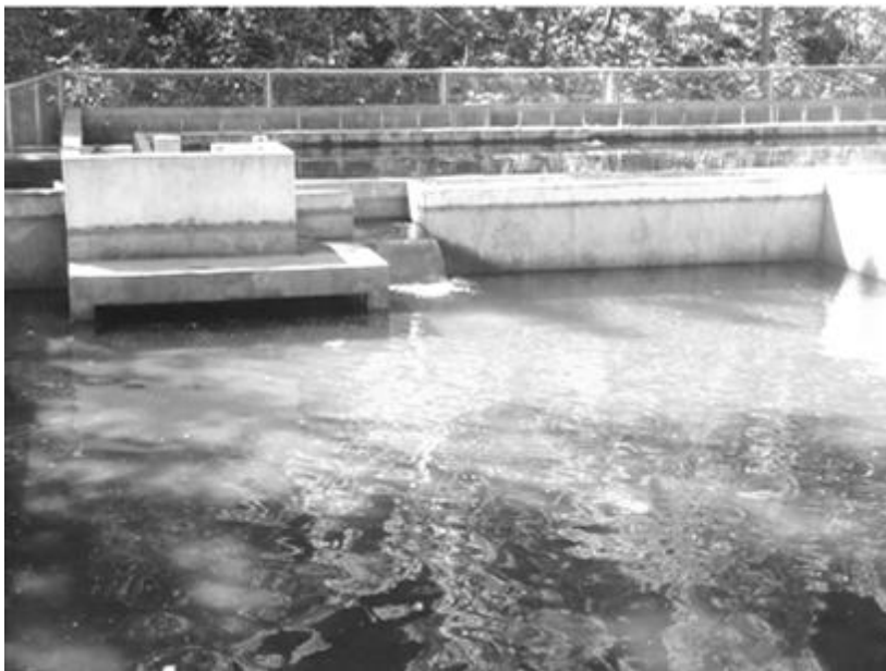
Figura 7. Filtro lento para potabilización
