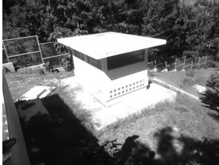
Figura 8. Caseta de cloración
