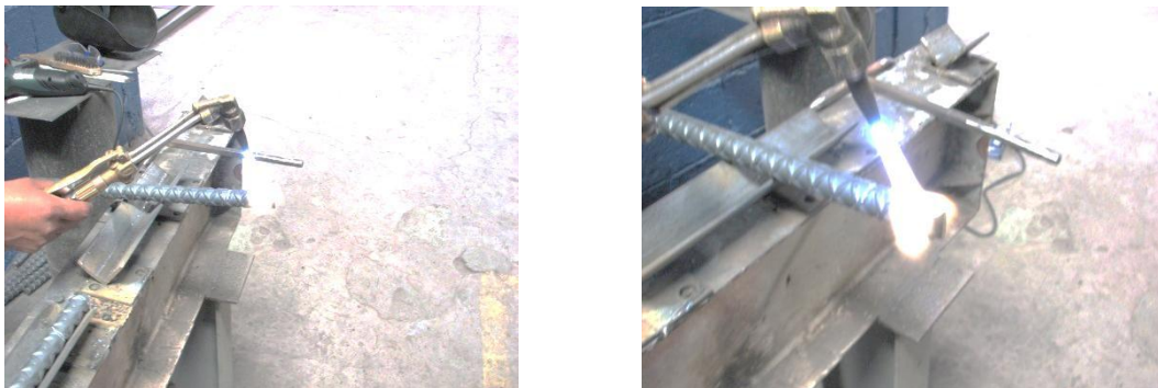
Figura 26. Pre calentamiento con antorcha
