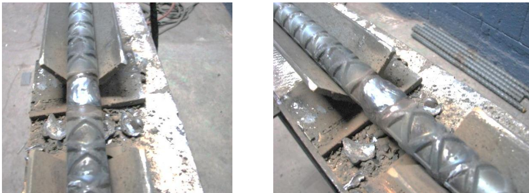
Figura 33. Barras en proceso de soldadura
