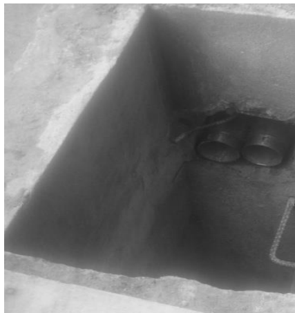
Figura 5. Fotografía del ducto único municipal
