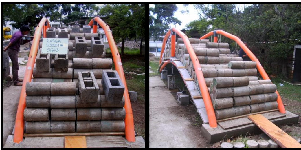
Figura 44. Ensayo de puente peatonal con el 60 por ciento de carga adicional a la carga de diseño
