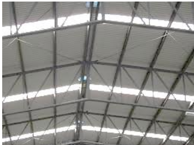
Figura 10. Iluminación natural de la bodega
