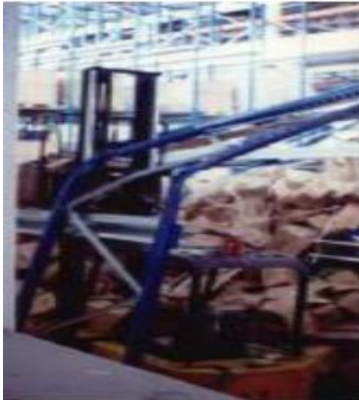
Figura 2. Colapso de la estantería metálica
