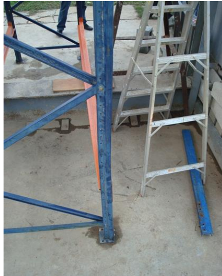
Figura 20. Torsión en el puntal A
