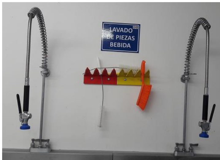
Figura 29. Cambio de mangueras de aspersion de estantes de lavado
