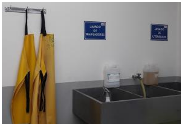
Figura 37. Estantes de lavado de trapeadores y utensilios
