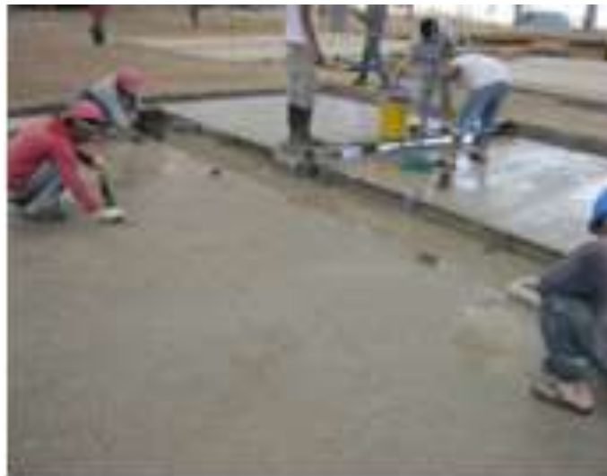
Figura 12. Aplicación de granito
