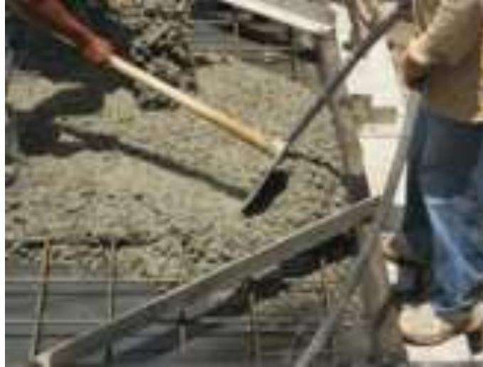
Figura 11. Fundición de muro
