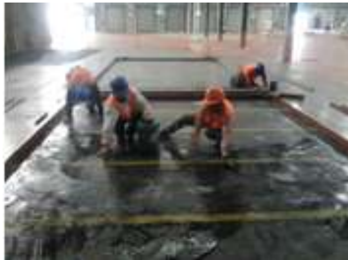
Figura 8. Aplicación de material antiadherente
