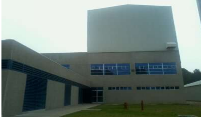
Figura 4. Oficinas y almacenamiento de papel
