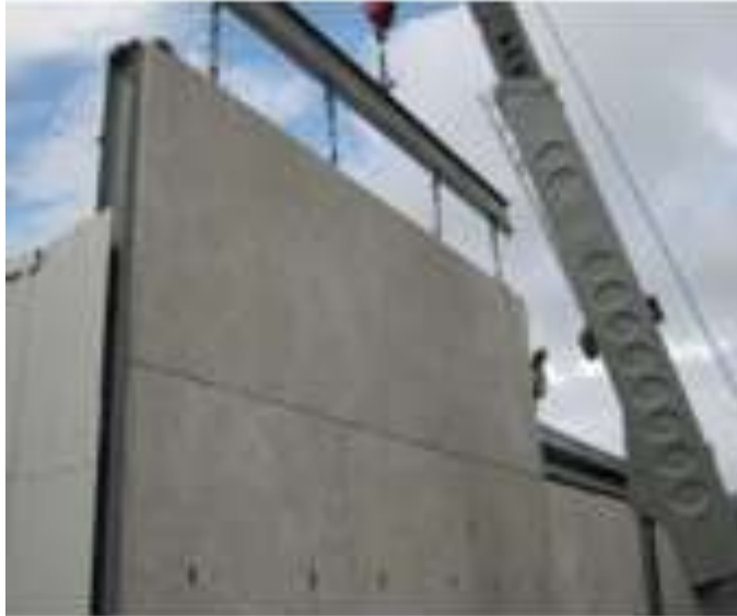
Figura 13. Izaje de paneles
