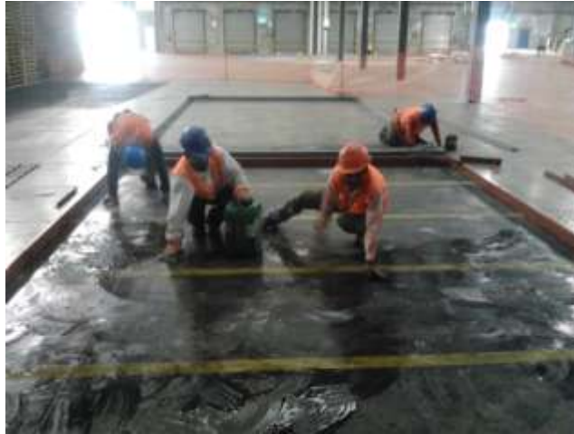
Figura 19. Aplicación de desencofrante y grasa
