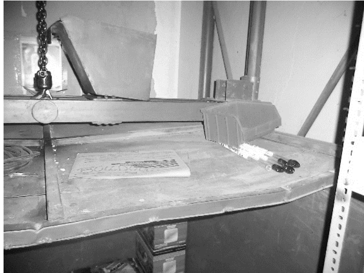
Figura 19. Riesgo de caída de objetos sobre elevador de carga
