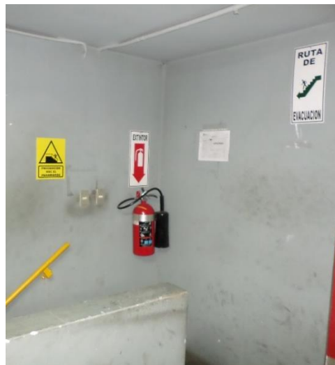
Figura 59. Señalización en área de bodega nivel 2
