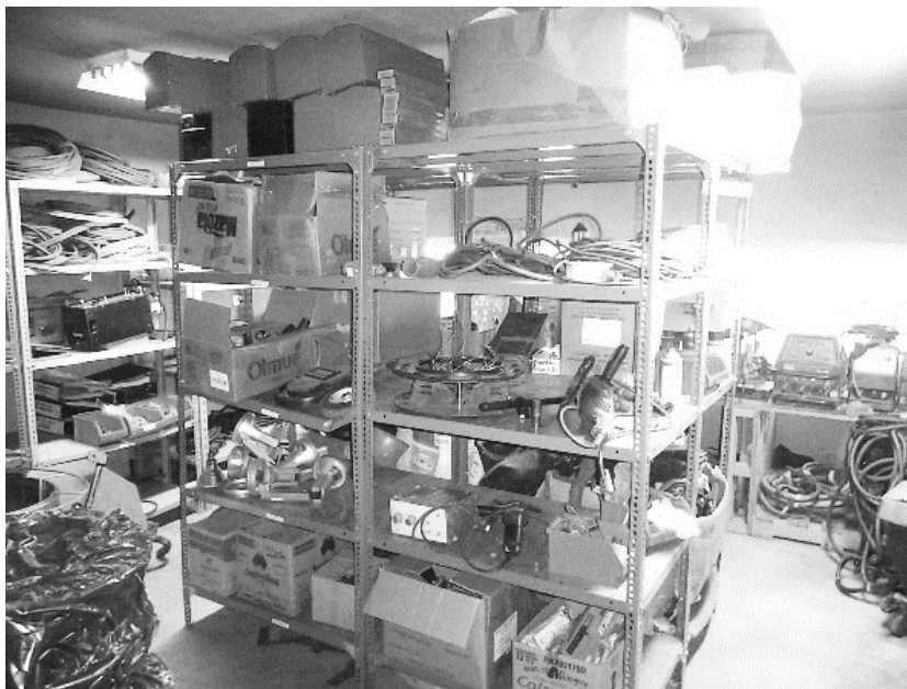
Figura 18. Riesgo de caída de objetos a distintas alturas
