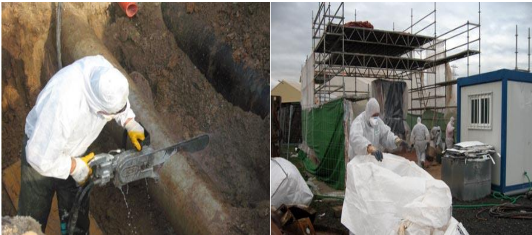
Figura 5. Condiciones de trabajo en la construcción con materiales y/o desechos peligrosos
