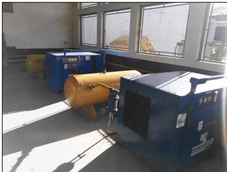
Figura 54. Ventanas del área de generación
