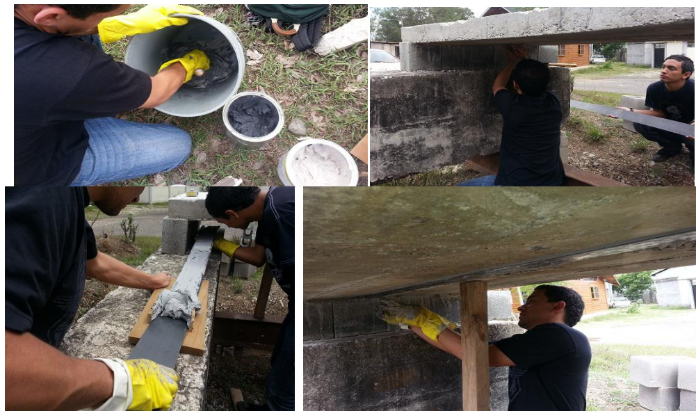
Figura 39. Instalación de la platina
