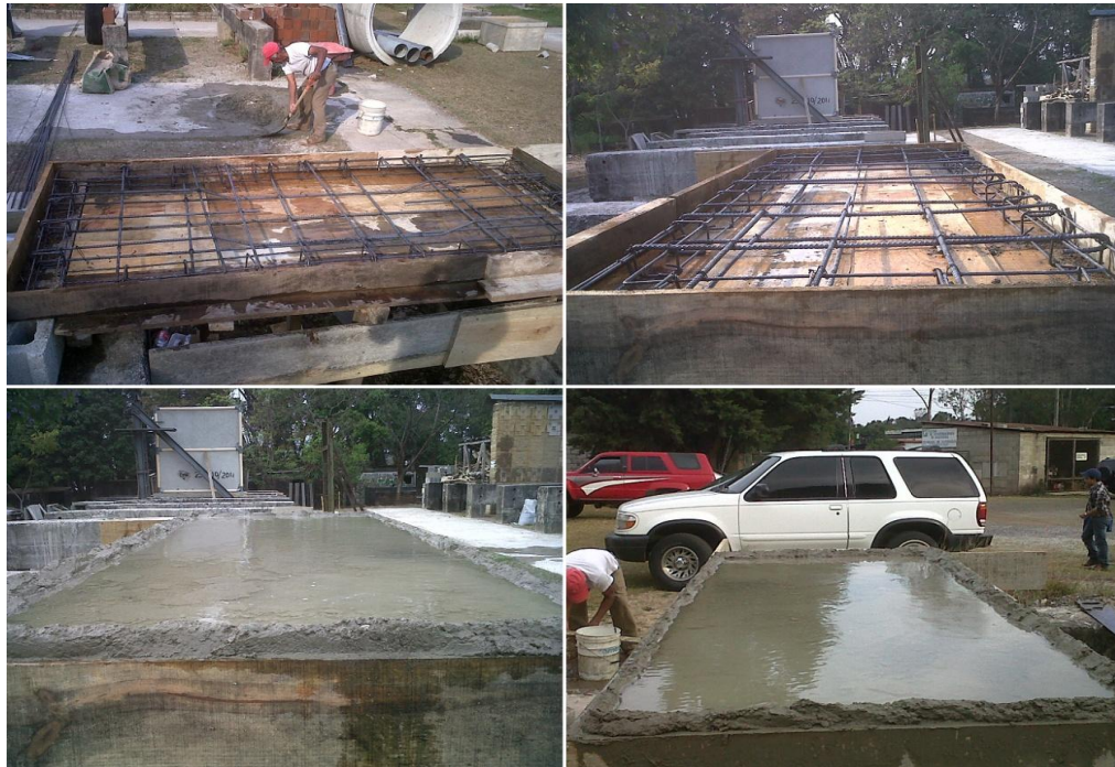
Figura 34. Construcción de losas a ensayar
