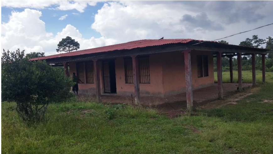
Figura 5. Casa de administración y albergue
