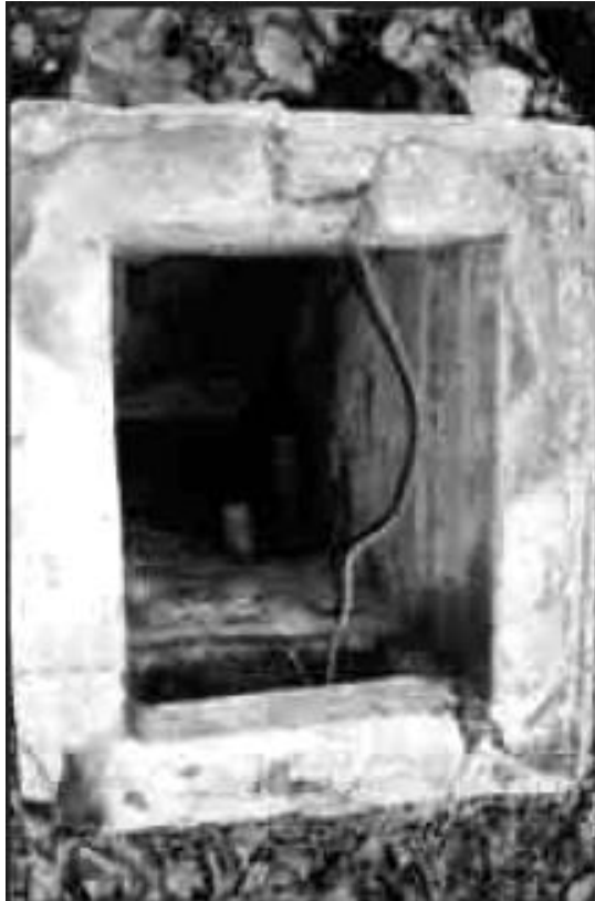
Figura 7. Pérdida de la fuente de agua luego de un sismo
