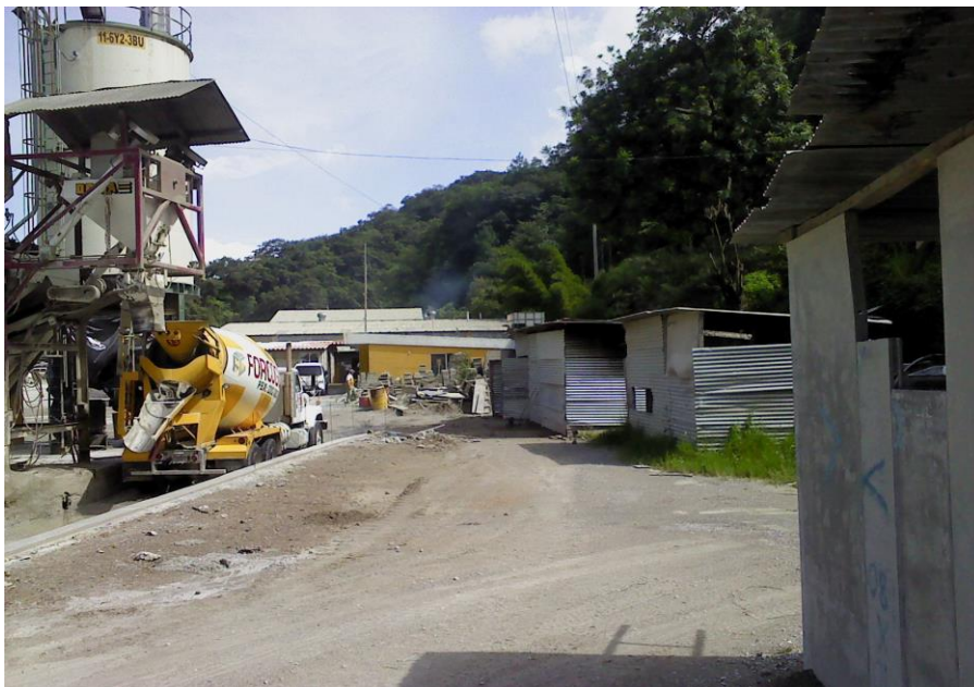
Figura 15. Área de llenado de camiones
