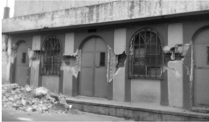
Figura 5. Casa ubicada en zona 3, San Marcos
