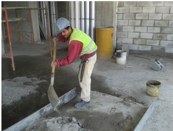
Figura 5. Muestra de sabieta fabricada en obra
