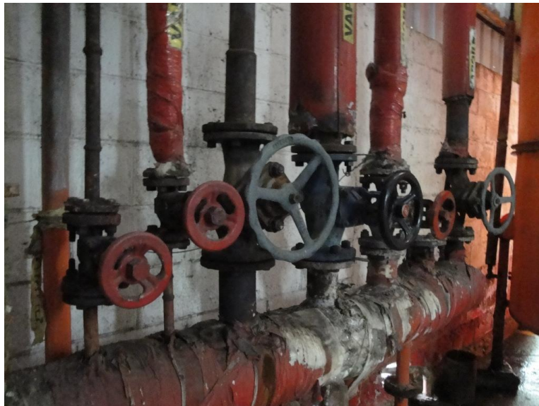
Figura 12. Aislamiento dañado/inexistente
